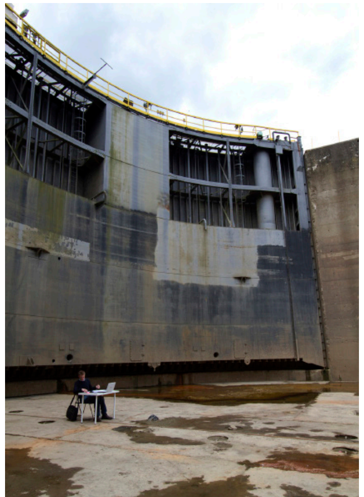
Jean-Baptiste en situation de travail dans la forme de radoub du port autonome de Bordeaux
